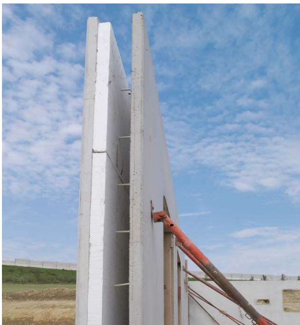
Dvojitá poloprefabrikovaná stěna s kotvami Schöck Isolink®
