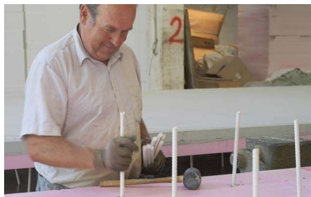
2. Nasazení kotev Isolink® do předem vyvrtaných otvorů v tepelně-izolační vrstvě
