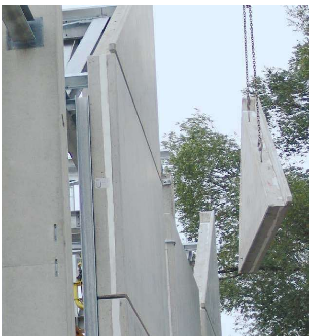
Sendvičová stěna s kotvami Schöck Isolink®
