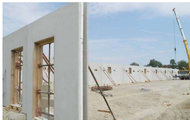
4. Osazení dvojité poloprefabrikované stěny s vloženou tepelnou izolací
