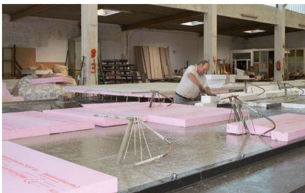
1. Položení tepelné izolace na čerstvě vybetonovaný povrch první stěnové desky
